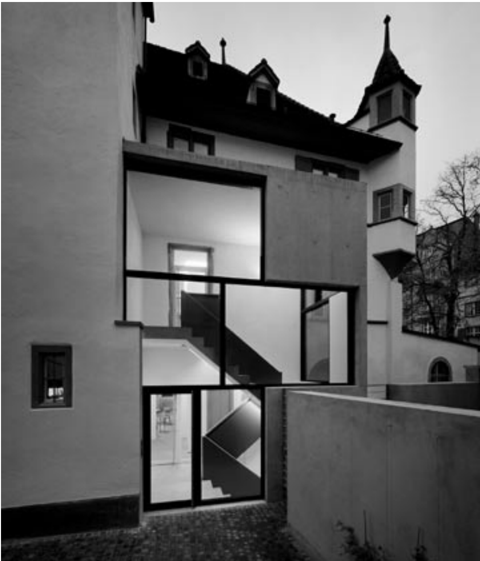
Treppenhaus mit separatem Zugang (Foto: Tom Bisig)
